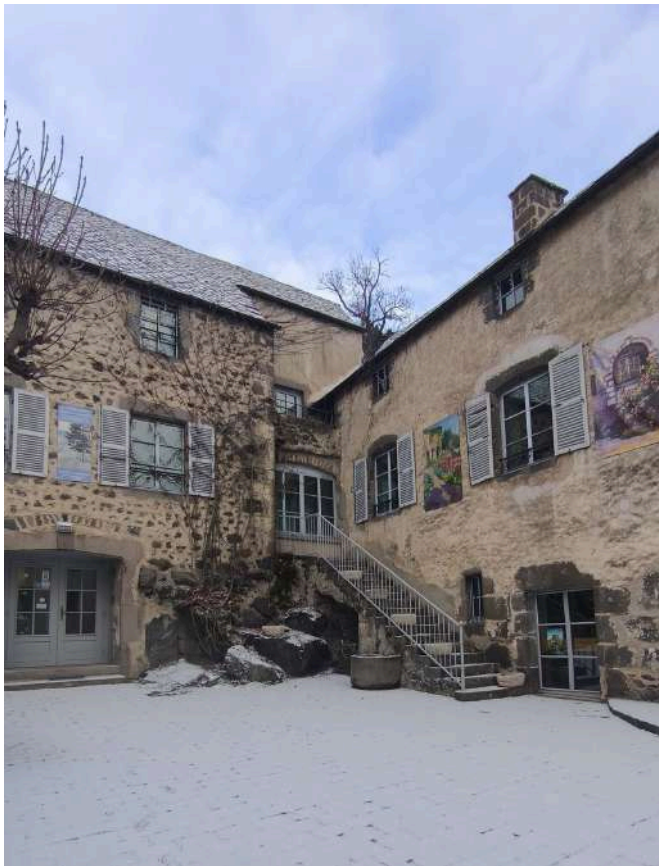
Bâtiment du musée
